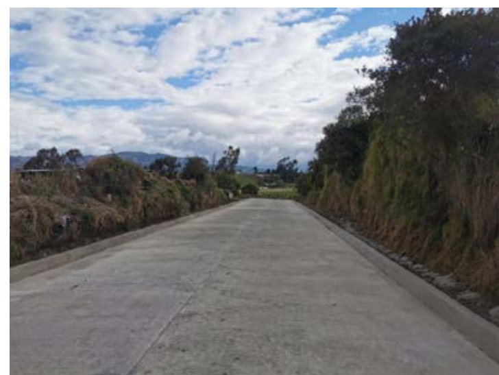
Vía Sapúyes - Túquerres
