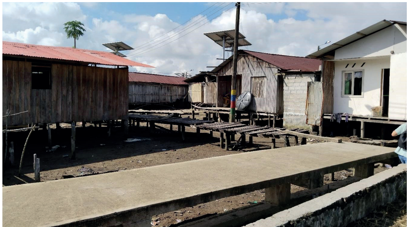
Reposición de puentes en madera por puentes en concreto.
